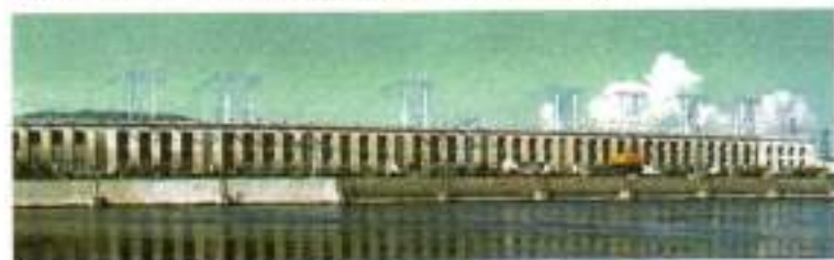
Рис. 13.1. Плотина Волжской ГЭС
